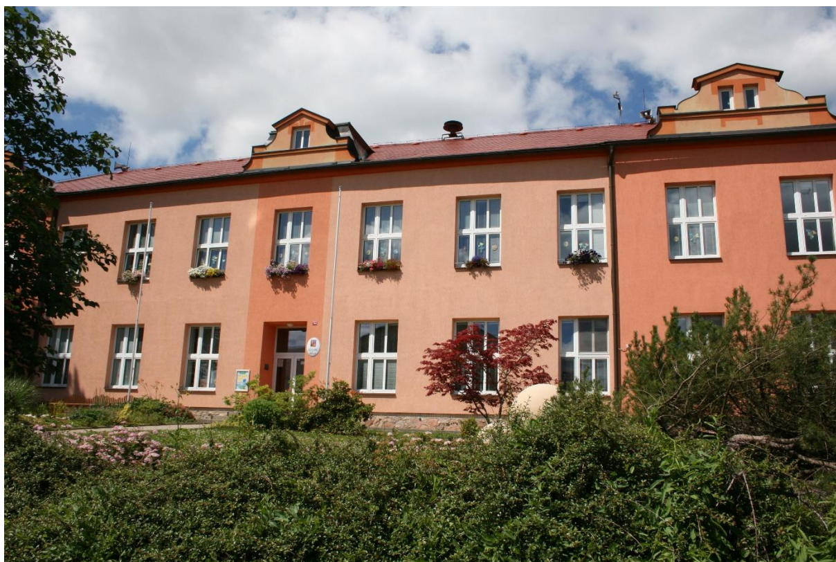
Obrázek 4 Budova základní školy
