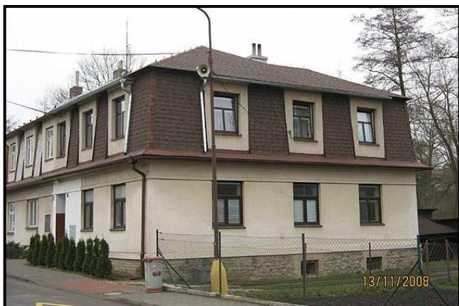
Výměna oken a střešní krytiny
