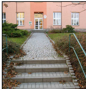
Žulové kostky před školou čekají na výměnu za zámkovou dlažbu
